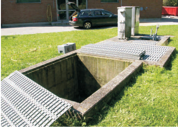
Vorhandener Auslaufschacht
