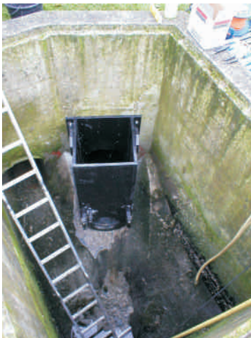
Montageadapter eingebaut
