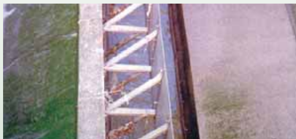
Grobstoffaustrag bei konventioneller Tauchwand
