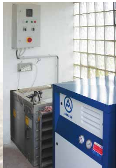
Steuer- und Belüftungseinheit
