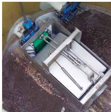
Abflussbegrenzer Typ Alpheus®-AT für halbtrockene Aufstellung
